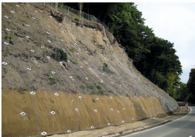
Укрепление склонов
